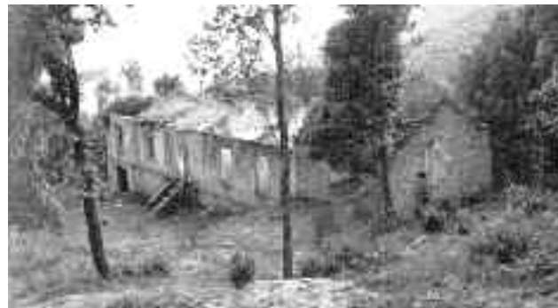
Fig. 4. Colle San Magno. Una delle strutture esterne della miniera, già in fase di avanzata decadenza, in una foto di alcuni anni or sono (Collez. privata Roccasecca)
