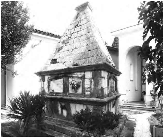
Fig. 13. La caratteristica tomba a piramide di Bartolomeo e Giacoma Pellegrini a destra lungo il Viale Centrale
